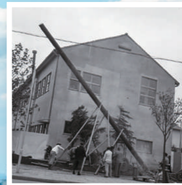
人力による建柱作業
