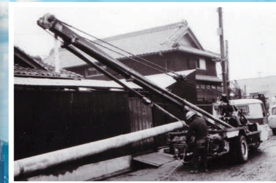
機械化車両による建柱作業
