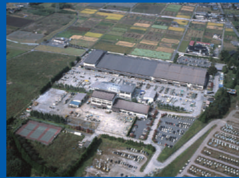
1985 (昭和 60) 年 多品種での効率よい生産 実現と先行した新技術 開発の拠点として、群馬県 に「新治事業所」を開設 しました
