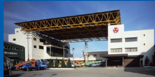
1980 (昭和 55) 年 お客さまにより分かりやすいご提案を行うための 「工法開発センター」を他社に先駆け開設しました
