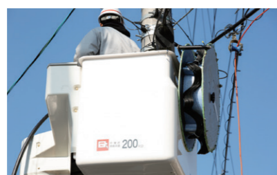
作業効率を考えバケットにリールをカスタマイズする工夫も
