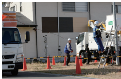
走ってきたトラックが架空ケーブルに接触し、ケーブルを持っていた作業員が脚立から転落した事故を再現
