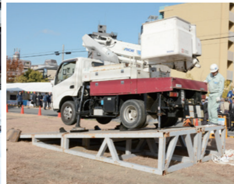
坂道での高所作業車の正しい設置手順を再確認
