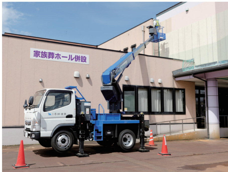
セレモニーホールの外壁塗り替え工事。アウトリガーの張り出しがないため、壁近くに作業車を設置できる
