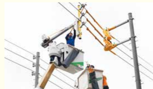
必要箇所に防具を取り付けた後、仮腕木の四面ローラーに電線を挿入し閉じる。仮腕木を上昇させる
