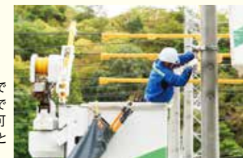
電柱に手が届く範囲までバケットを近づけることができ、待ち時間なく作業が可能。作業効率を上げることに繋がる
