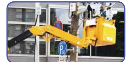
新しい電柱に移すために信号機を取り外す作業中。先端屈折アームでバケットを適切な位置に移動させる
