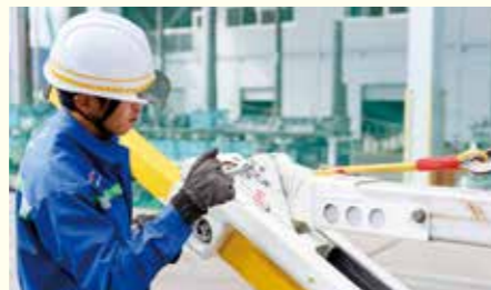
仮腕木は垂直だが、スライド起伏ヘッドの角度は変更することができる
