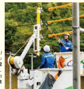
写真手前のYE303を取り付けた高所作業車のバケットが電柱側にあるため電線を仮支持するだけでなく、電柱作業も可能になる。お互いのバケットが近く作業のカバーがしあえる
