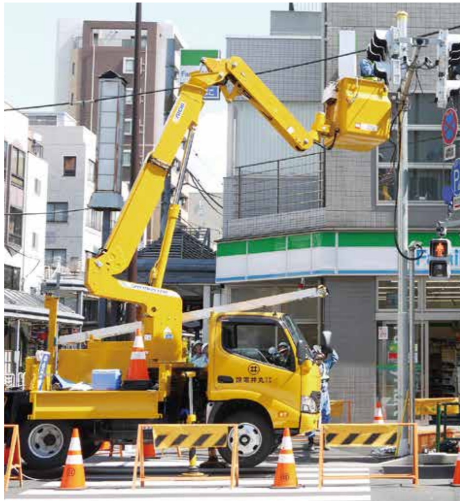
信号機を新たな柱に移設する作業。交差点内での作業は、周辺の安全管理が優先される
