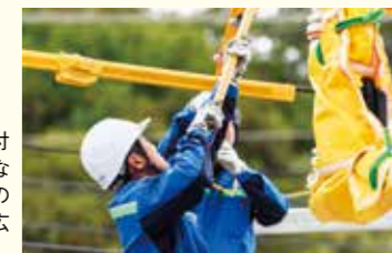
電線を碍子に止める、巻付バンドを取り付ける作業などがやりやすい。お互いのカバーもしやすく、視野が広がるというメリットがある
