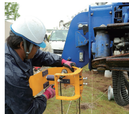
穴掘建柱車への把持具の装着は5、6分で終わる
