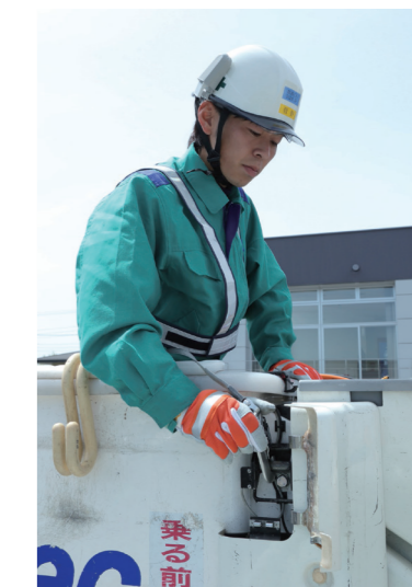
バケットの安全帯ロープ取付確認装置に安全帯フックを掛け替える。
