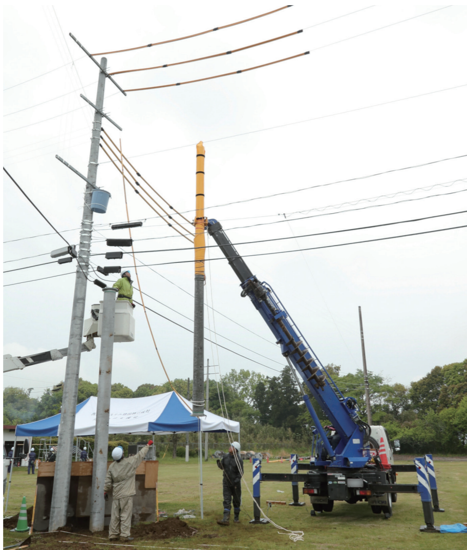
分割柱把持具を使った作業の様子 ※今回の取材では安全に配慮し、研修施設内で模擬柱を使用しています。
