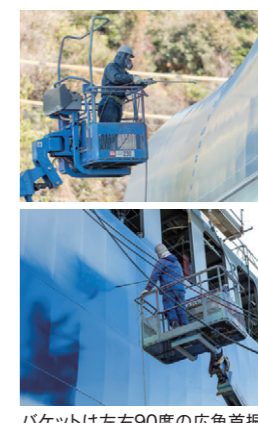
バケットは左右90度の広角首振りが可能。また、レバー1本で垂直・水平方向への移動も簡単に行える
