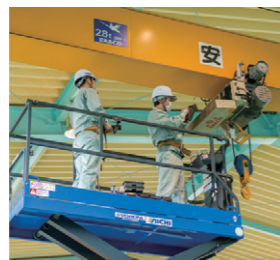
天井クレーンのメンテナンス
