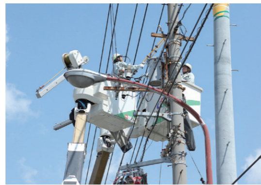
2台1組での作業の様子。左手前が2tシャシのバケット、右手奥が多関節型3tシャシのバケット。
