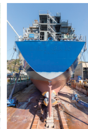
新造船の塗装工程。船体の片側に3台ずつ高所作業車を配置しての作業
