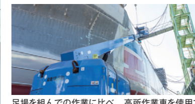
足場を組んでの作業に比べ、高所作業車を使用することで安全性も高まった
