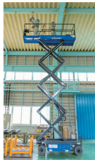
天井の水銀灯の交換作業。部品などがある場合もスライド式拡張デッキにより、作業ポイントの真下まで到達できる
