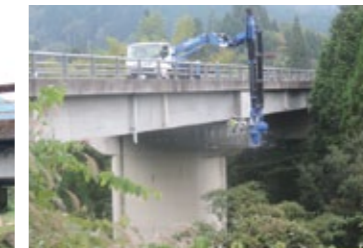
水面から高さがある橋でも橋梁点検車なら無理なく作業がこなせる
