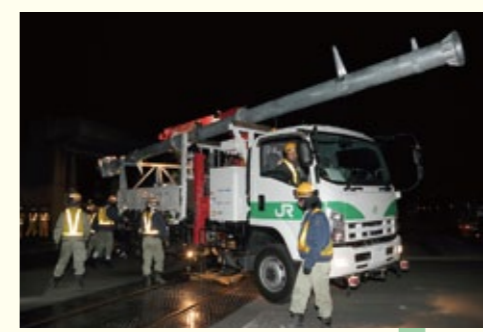
① ビームを積んだUJ083の載線作業
