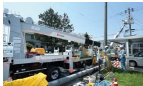
D70Aハイブリッド仕様と高所作業車、排土を運ぶトラックが連携した、建柱と撤去工事の様
