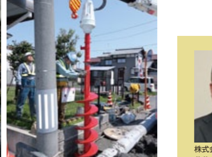
バッテリー駆動のオーガによる掘削作業
