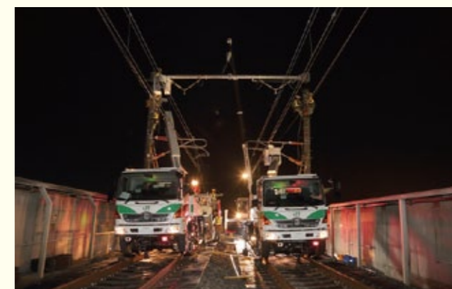
④ クレーンで吊り上げた長さ約10m・重さ600～1000kgのビームを2台のLK17KFEが電化柱の頭部に据え付ける。この工事でもっとも緊張する山場だ
