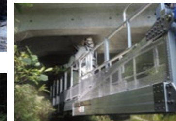
“近接目視”には橋梁点検車が必要不可欠
