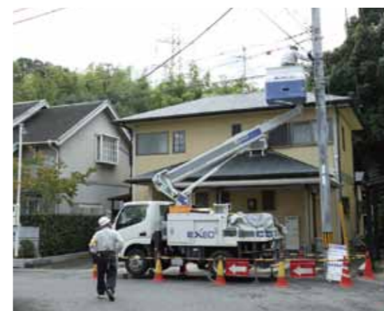
作業現場は周囲の状況によって、傾斜には気が付かないこともある
