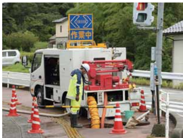
「作業中」の電光掲示板を上げた支援車。すべての必要機能をコンパクトに搭載した総重量5t未満
