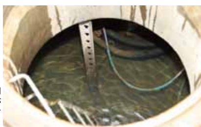
マンホールの蓋を開け、最初にするのが排水ポンプを入れての排水作業
