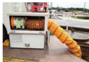
送風機で常に新鮮な空気をマンホール内に供給する
