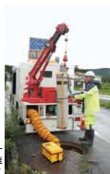
定格荷重200kgのミニクレーンで重い圧縮空気ポンペを軽々とマンホール内に吊り下ろす
