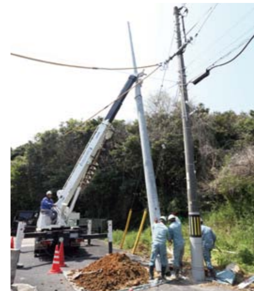
コンクリート柱の重心近くに治具を取り付けると、クレーンで吊り上げるだけで柱が見事に建ち上がる
