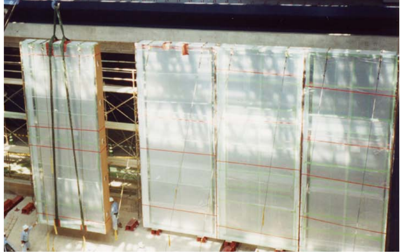
沖縄美ら海水族館での設置風景。巨大なパネルをつなぎあわせ、まるで一枚かのように仕上げる。その決め手は“職人の勘”
