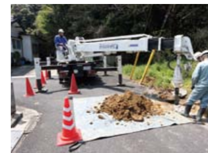
コンクリート柱の重心近くに治具を取り付けると、クレーンで吊り上げるだけで柱が見事に建ち上がる
