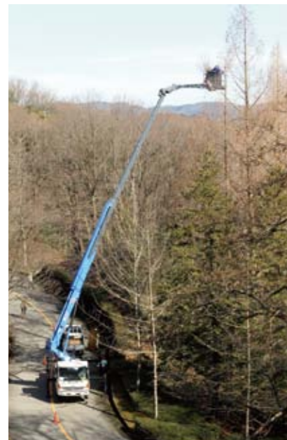
屈折する先端のバスケットが樹間に入り込む。作業半径が広いので、作業が一層スムーズに行える
