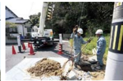
埋設物の破損トラブルを防ぐために必要な手掘り作業は、重労働だ
