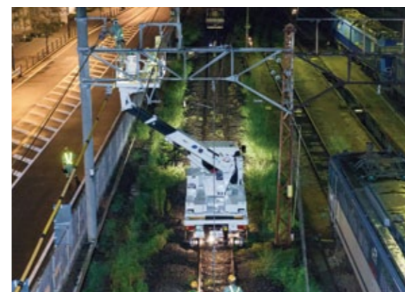
写真はアーム部分の作業だが、線路左側の電線引き留め柱(コンクリート柱)までも余裕で作業範囲に収まる
