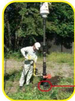
埋設物の破損を防ぐ特殊な形状を持たせたオーガ刃先 (写真はデモンストレーション用)
