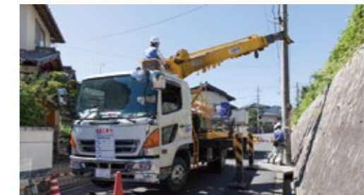
撤去電柱をクレーンで支える
