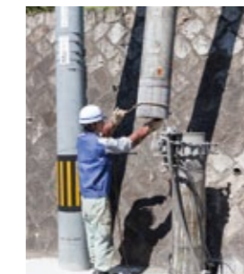
切断した後、吊り下げて地上に寝かせる。電柱を吊り上げずすむため、周囲の電柱設備と接触の危険性が格段に低くなる
