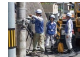
スイッチを入れればカッターが電柱周りを自走し、短時間で切断する
