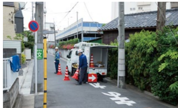
軽自動車サイズでジャッキの張り出しがないため、これまで駐車できなかった道幅の道路でも駐車して作業が行える
