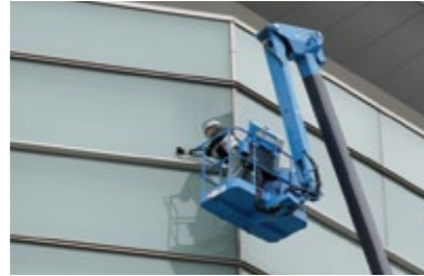
機に沿って水平移動しながら、機に埋め込まれた照明器具の点検がこの日の作業
