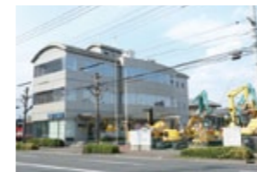
前橋市内にあるニッパンレンタル様の本社とストックヤードの一部
