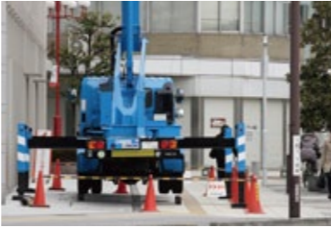
ビルの壁面ピットリに幅寄せしたSJ30ARS
