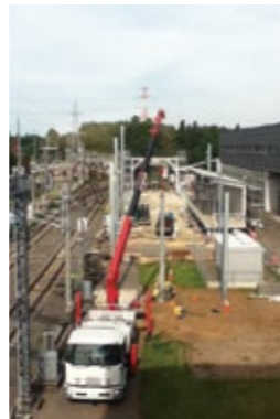
様々な作業が試されたというNDK様「中央学園」増設工事での1シーン
