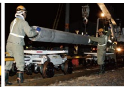
クレーンで吊上げた電柱をトロに載せる
