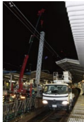
4.9t吊クレーンのパワーで鉄骨製支柱を高々と吊上げる
