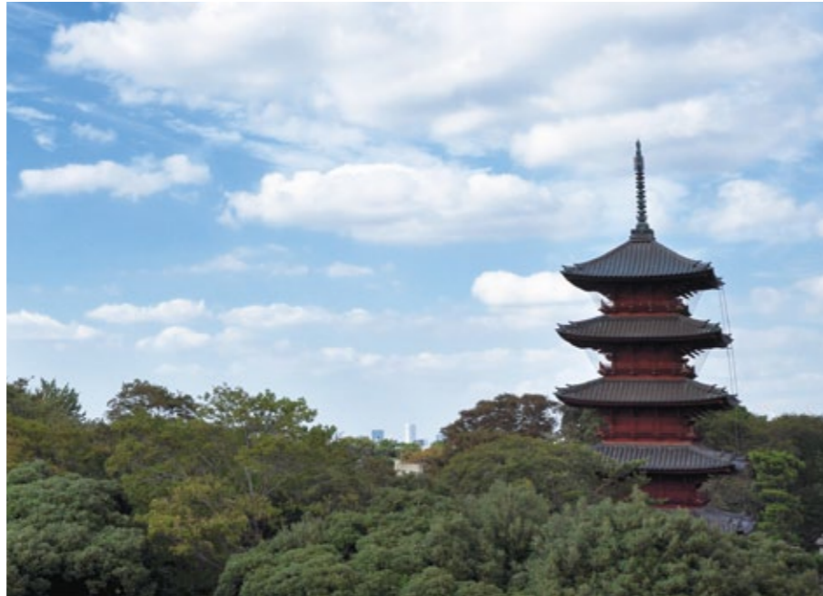
池上本門寺五重塔は、度重なる修理などにより姿を変えていたが、創建当時の資料などをもとにした菊池棟梁たちによる解体・修復により、当初の美しい姿を取り戻した
