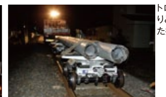
トロにしっかりと固定された撤去電柱
