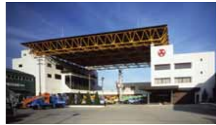
1980(昭和55)年、お客さまにより分かりやすいご提案を行うための「工法開発センター」を他社に先駆け開設しました
