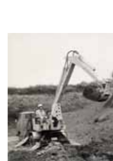
B160型 バックホー 1969(昭和44)年 「掘る」ためのバックホーを開発しました
