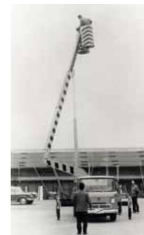
高所作業車1号機 1965(昭和40)年 建柱後の柱上作業の安全確保と効率化のため、高所作業車を開発しました
